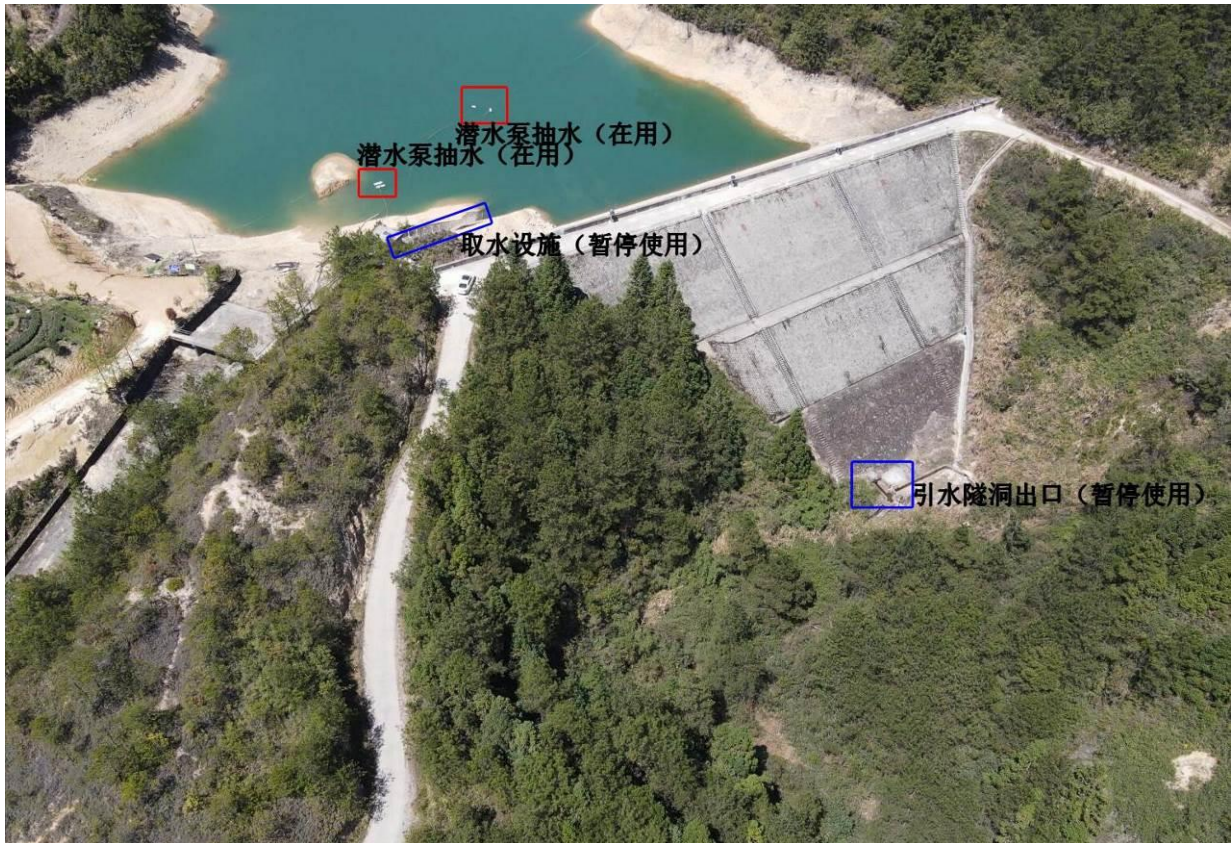
图3.5-3 纯池水库现有取水设施
