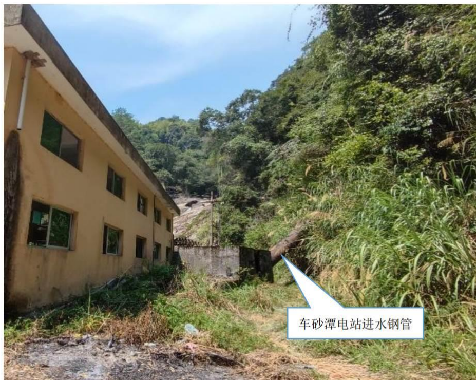
图3.5-1 车砂潭电站现有钢管处
